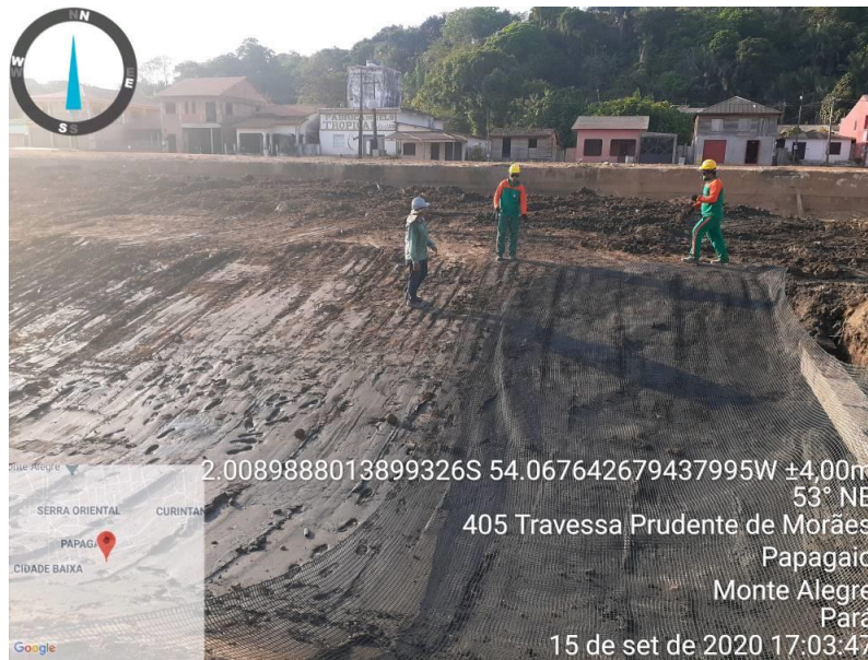
Fotos 22 a 25- Fornecimento, Lançamento e espalhamento da pedra de mão- Trecho 02
