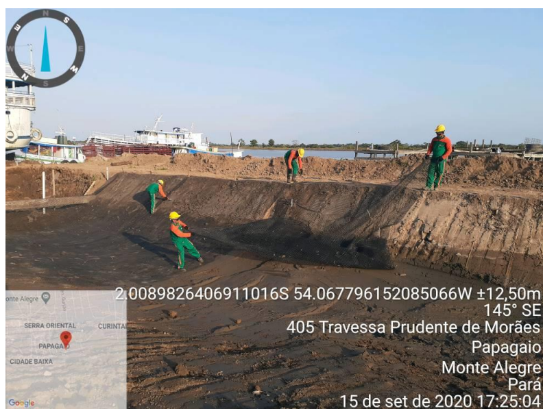
Fotos 20 e 21- Preparação e Instalação da Geogrelha- Trecho 02
