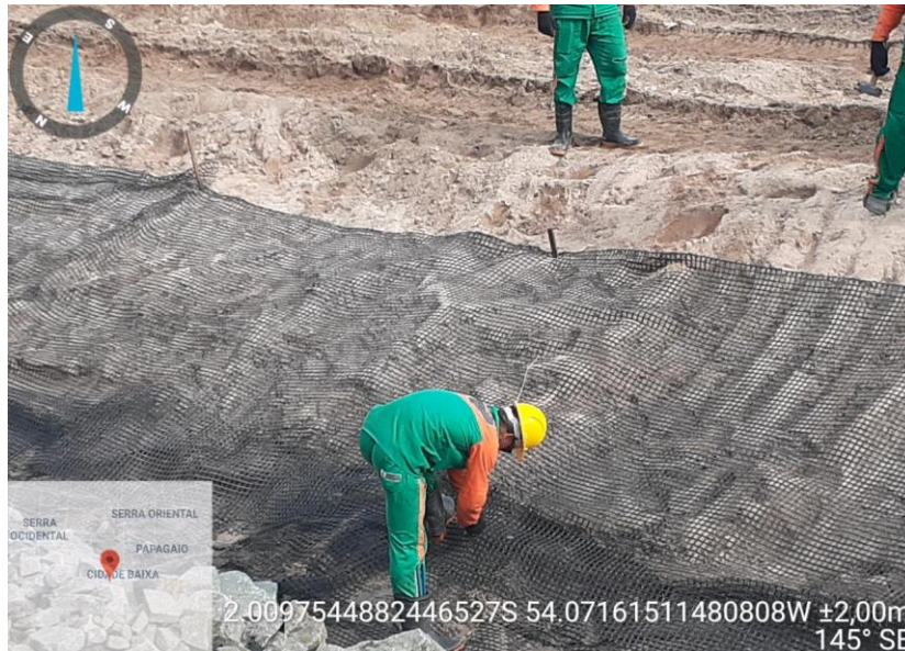
Foto 35 - Preparação e Instalação da Geogrelha
