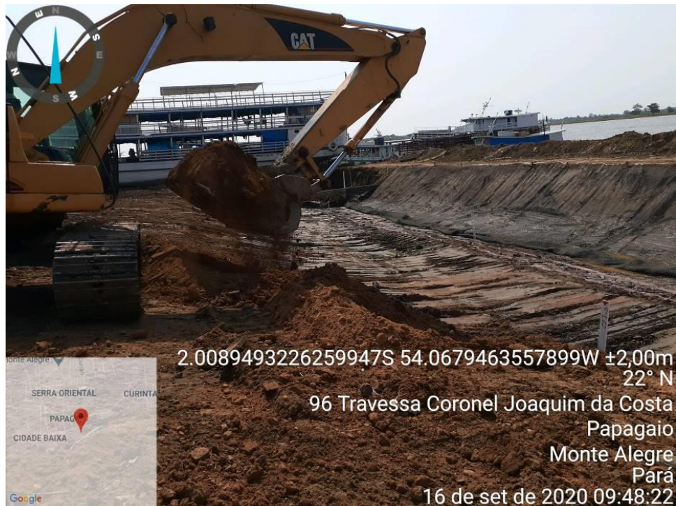
Fotos 16 a 19- Escavação Mecanizada- Trecho 02
