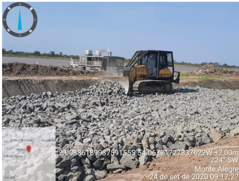
Fotos 26 e 27- Execução do Dique de Contenção- Trecho 02- Continuação
