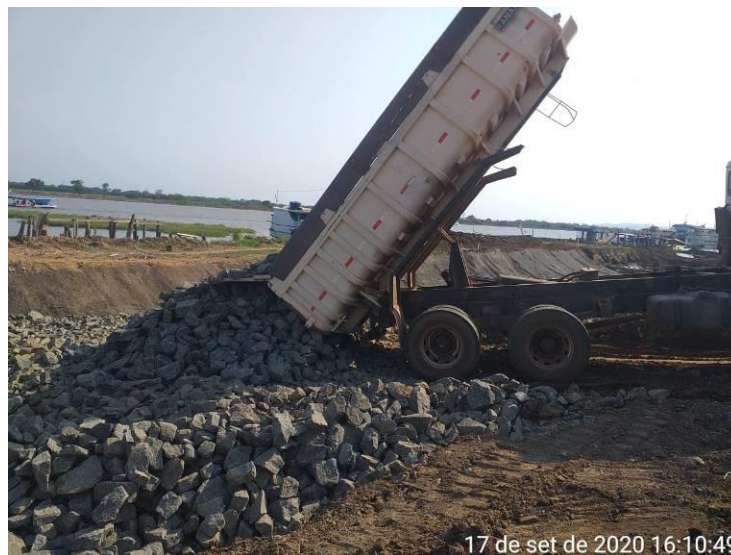
Fotos 22 a 25- Fornecimento, Lançamento e espalhamento da pedra de mão- Trecho 02
