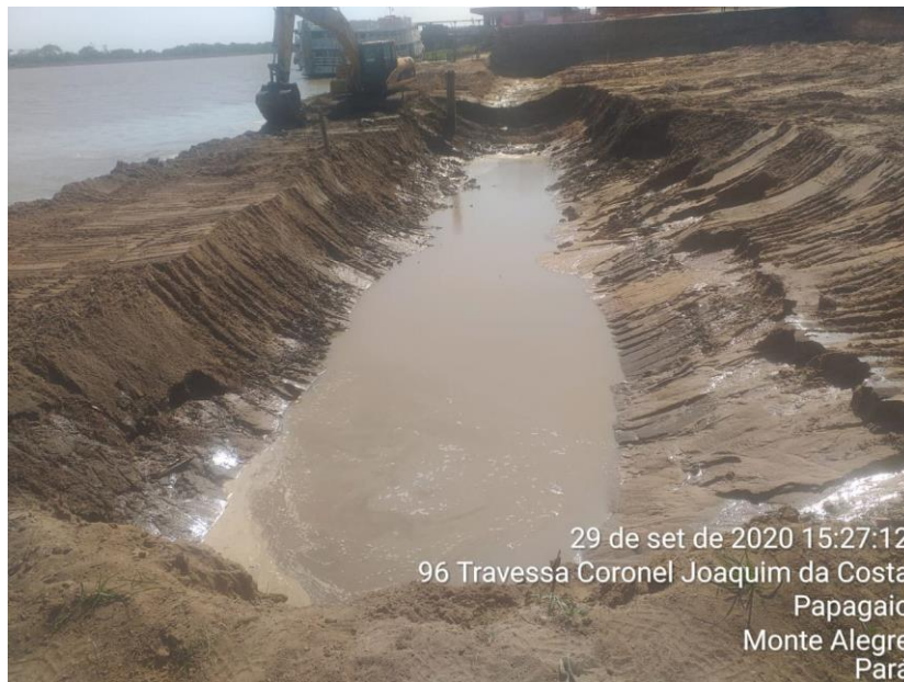
Foto 28 - Execução de Dique de Contenção
