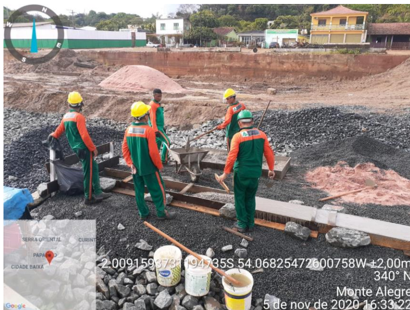
Fotos 34 - Execução de Soleira em Concreto Simples
