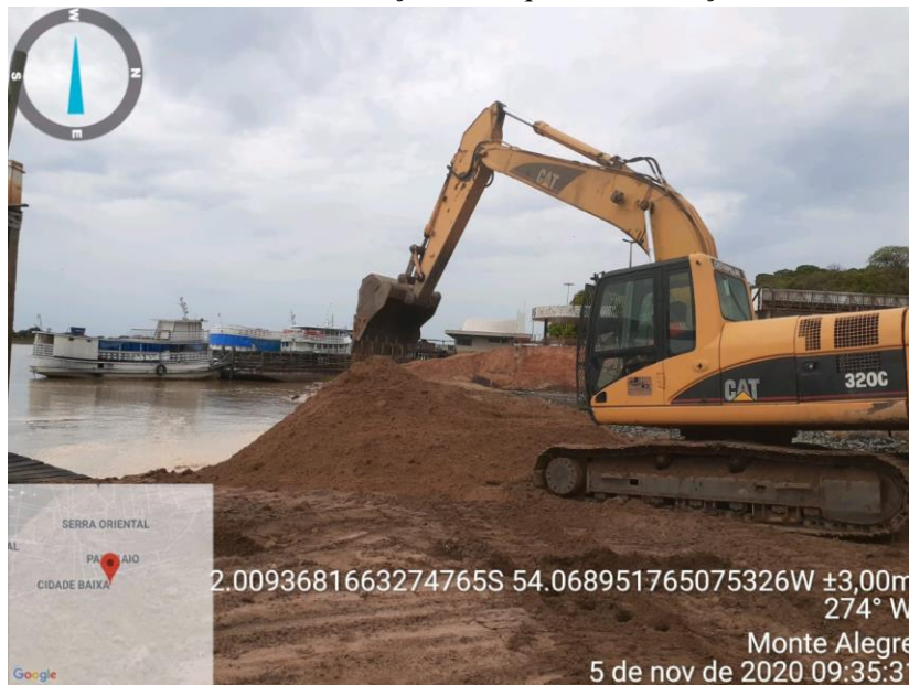
Foto 28 - Execução de Dique de Contenção
