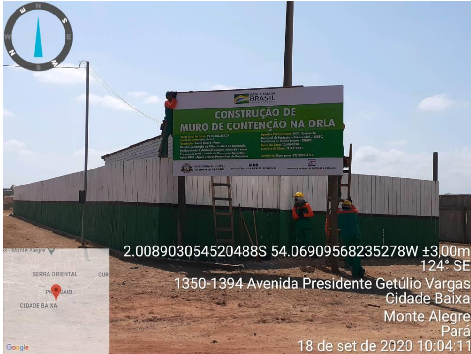
Foto 15- Fixação da Placa de Obra- serviço sem previsão em planilha
